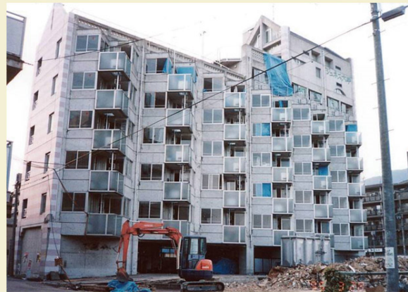
【写真1】 1995年阪神・淡路大震災で倒壊は免れたがひび割れ等の損傷が大きいため最終的に取り壊された建物 ©福山洋
