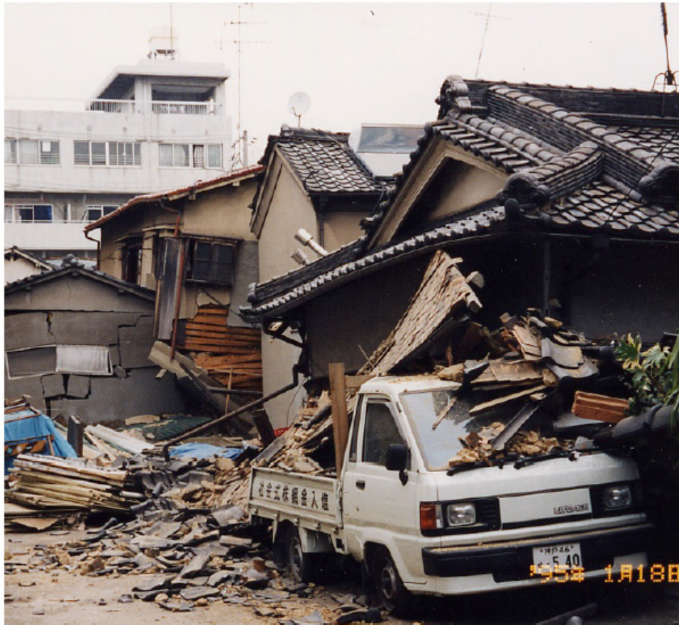
耐震性能が低い建物の壊れ方
