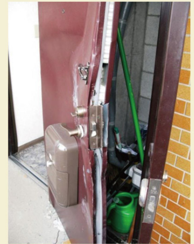
【写真2】 2011年東日本大震災で大きな損傷を受けたマンションの鉄筋コンクリート非構造壁と開閉困難となったドア
