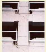
【写真1】 1995年阪神・淡路大震災で倒壊は免れたがひび割れ等の損傷が大きいため最終的に取り壊された建物 ©福山洋
