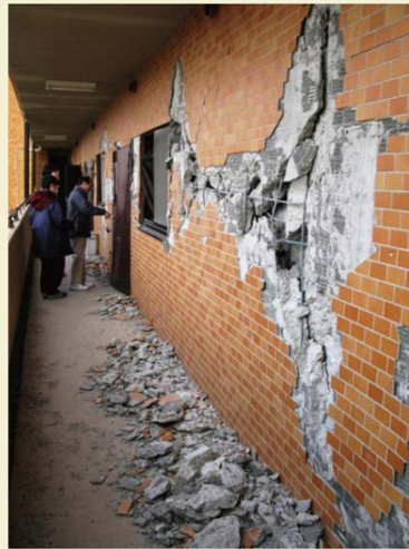
【写真2】 2011年東日本大震災で大きな損傷を受けたマンションの鉄筋コンクリート非構造壁と開閉困難となったドア
