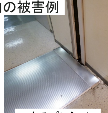
エクspansion ジョイントのずれ
