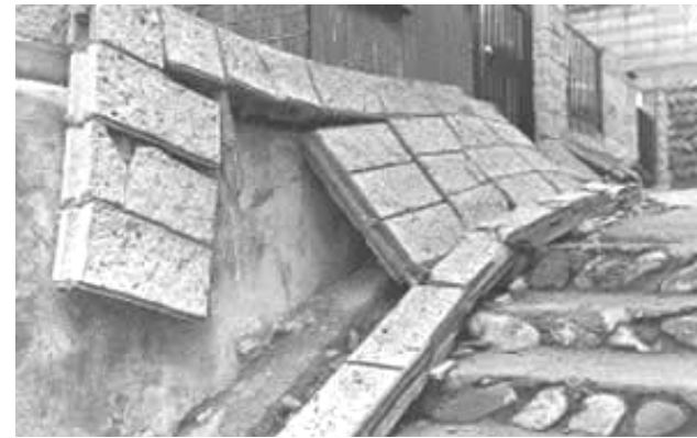
宮城県沖地震のブロック塀被害(1978)
