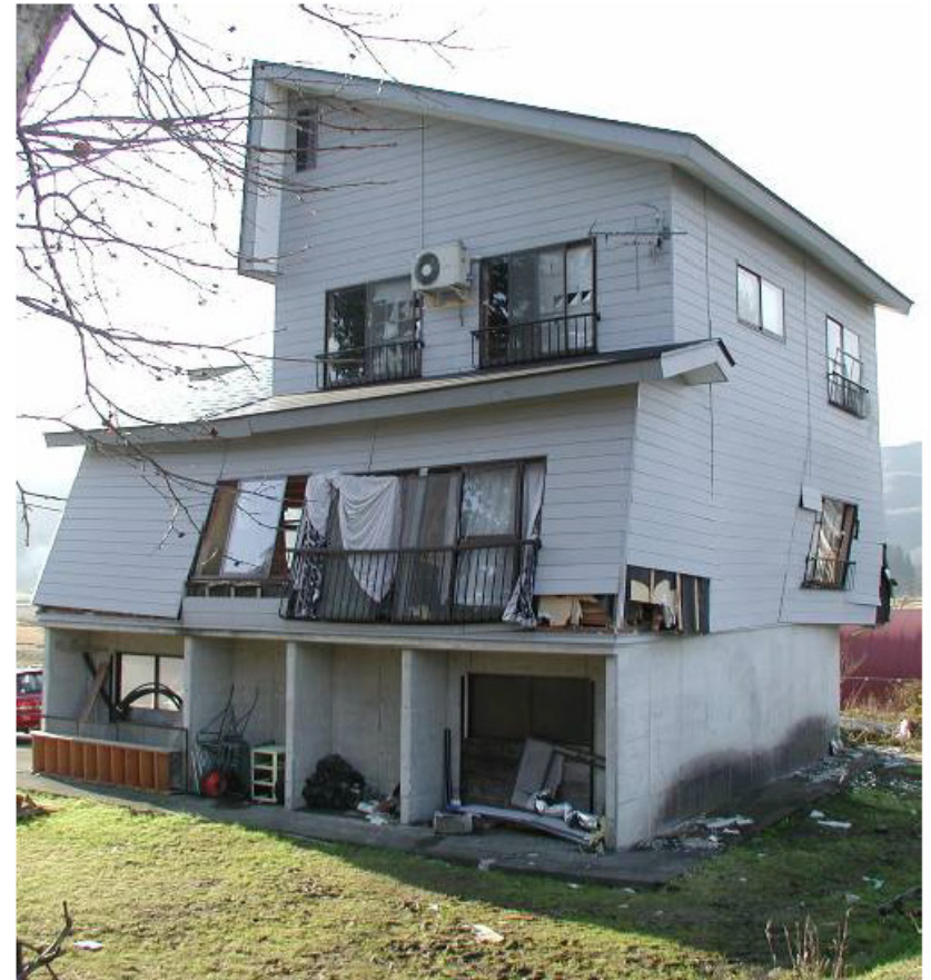
一定の耐震性能がある建物の壊れ方
